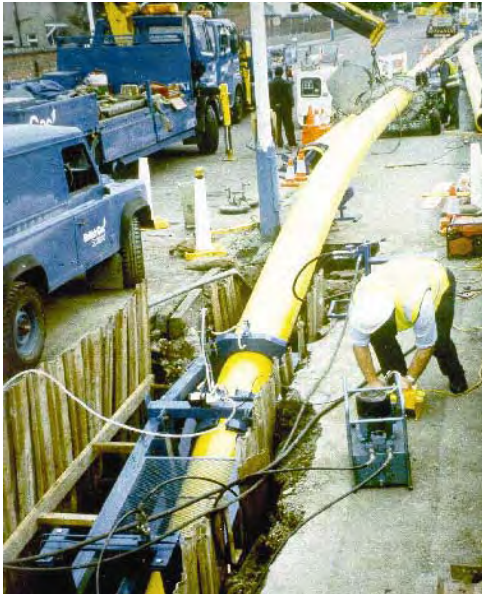
Figura 1 “Swagelining” de tubería para reemplazo
